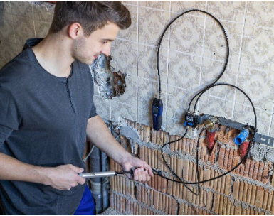
Fig. 37: Aansluitvoorbeeld met de Wöhler gasleiding-lektestset voor de belastingstest
