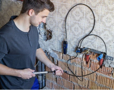
Fig. 32: Oppompen van de waterleiding met lucht, lektestfitting aangesloten op waterleiding via hogedrukstomp
